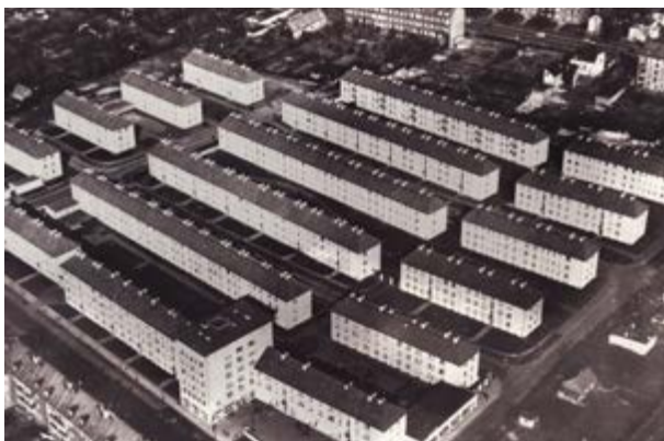
Der Rübenkamp 1955/56: Die kasernenartig aufgereihten Häuser wurden als Schlichtbauten umgesetzt. Zur Herstellung wurde Ziegelsplitt als Baumaterial verwendet.
