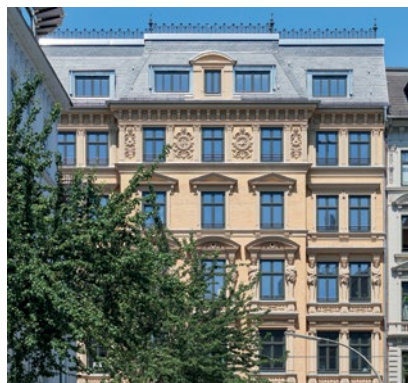
Umfassende Gebäudesanierung eines denkmalgeschützten Hauses in der Langen Reihe 67
