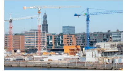
Im Jahr 2004 begann der Bau in der HafenCity. Am Kaiserkai entstanden 17 Wohnungen und zwei Läden.
