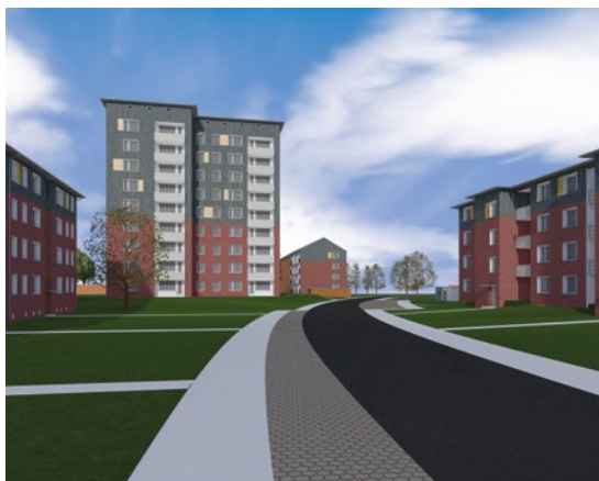
So soll sie bald aussehen: Unsere Wohnanlage im Von-Herslo-Weg in Hamburg-Schnelsen nach der energetischen Modernisierung
