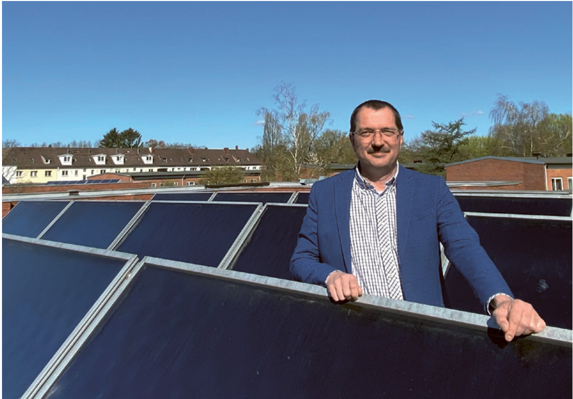
Andreas Majeri auf dem Dach eines unserer Häuser im Quartier Rübenkamp. Dort befindet sich eine Solarthermieanlage zur Unterstützung der Warmwasserbereitung.
