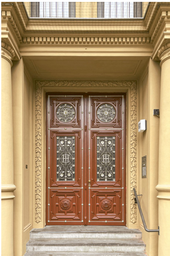
Das Eingangsportal mit seinen historischen Elementen wurde wiederhergestellt.
