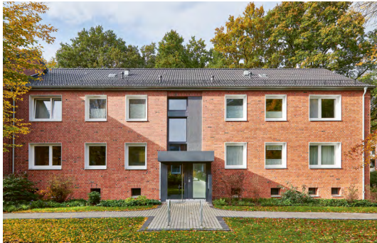
Das obere Bild zeigt ein dreigeschossiges Mehrfamilienhaus vor der energetischen Modernisierung. Das untere Foto zeigt ein zweigeschossiges Mehrfamilienhaus, nachdem die Modernisierung abgeschlossen ist. Deutlich erkennbar ist das neue Dach, die gedämmte Fassade und der großzügige neue Eingangsbereich.
